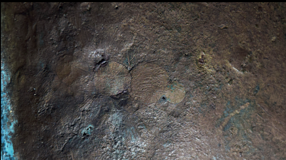
Barre filettate, sistema di riparazione, particolare della schiena
